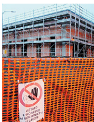
Il cantiere di Angera
